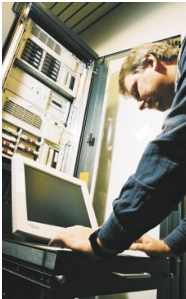
Im AOV Rechenzentrum laufen die Daten und Systeme vieler Stadtwerke zusammen.
