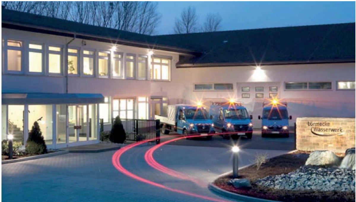
Das Lörmecke-Wasserwerk in Erwitte
