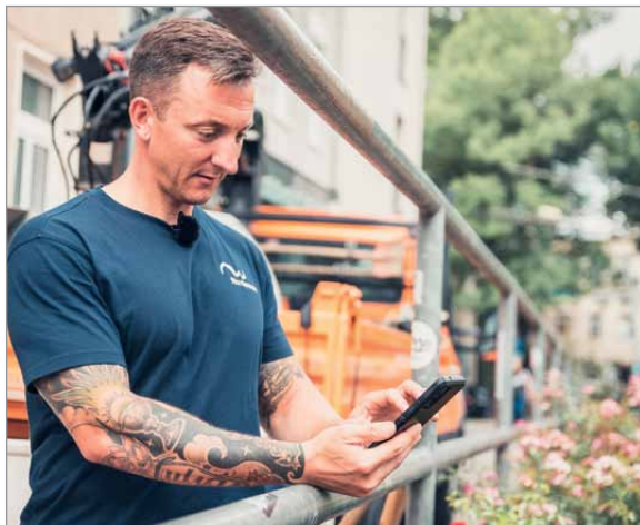
Nach Anschlusslegung erfolgt direkt die Einmessung per Smartphone.
