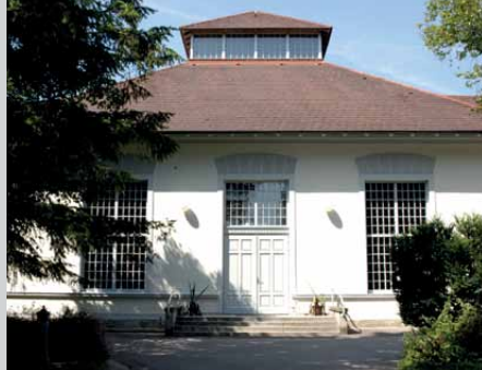
Wasserwerk Scharnitz, LINZ AG
