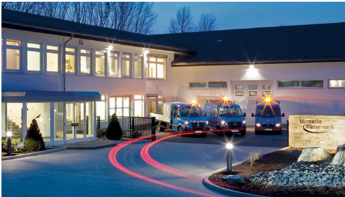
Das Lörmecke-Wasserwerk in Erwitte
